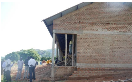
建設中の理科実験棟
