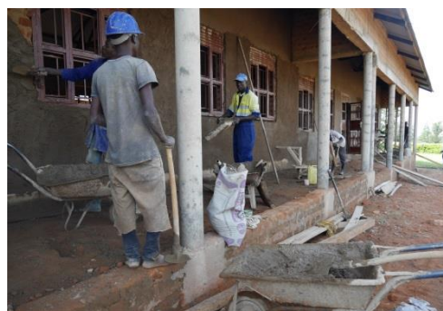
建設が順調に進んでいる
