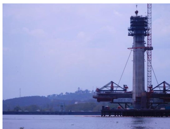
建設中の新ナイル橋
