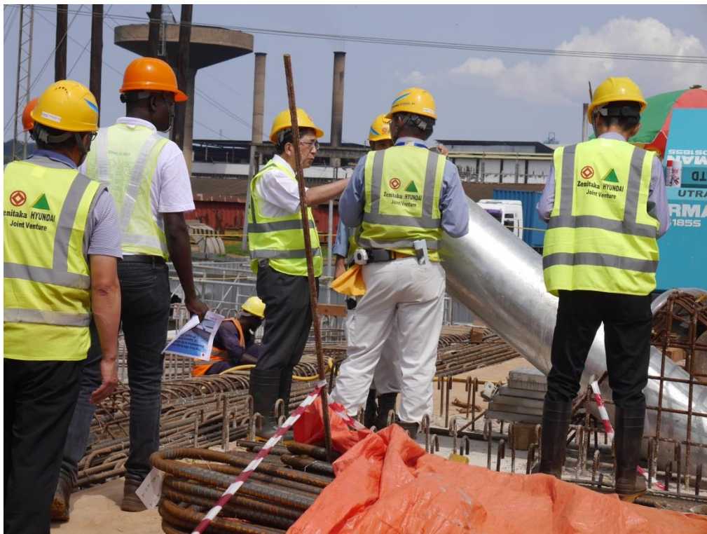
②ナイル架橋建設現場を視察する亀田大使
