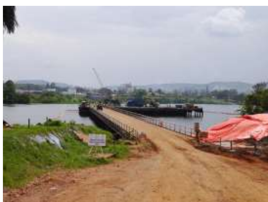
(2016年8月の工事現場)
