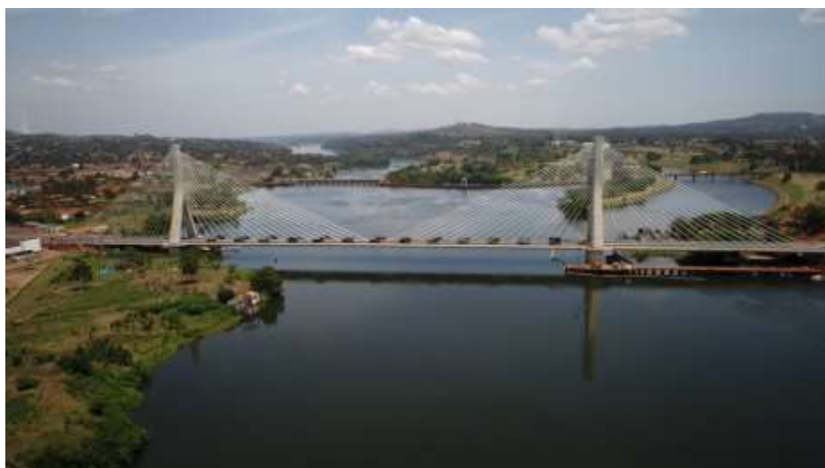
(ナイル川源流橋全景—奥に見えるのが旧ナイル架橋)
