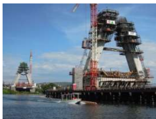
(2017年4月時点のパイロン建設風景)
