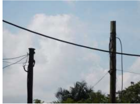
(公邸前の街路の頼りない電柱)
