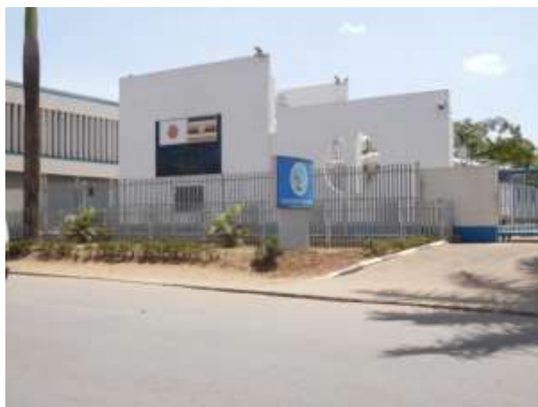
(生まれ変わったクィーンズウェイ変電所)
