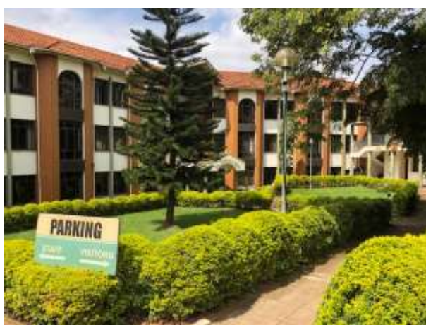
(カンパラにあるUWA本部の建物)
